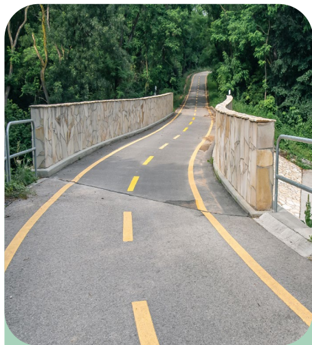
Nadapi híd és kerékpárút
